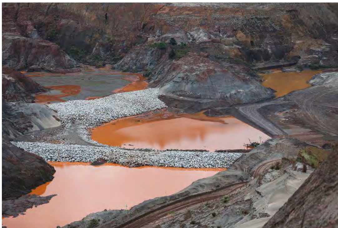
Figura 53 Exemplo de Diques implantados no Rompimento da Barragem de Fundão em Mariana – MG
