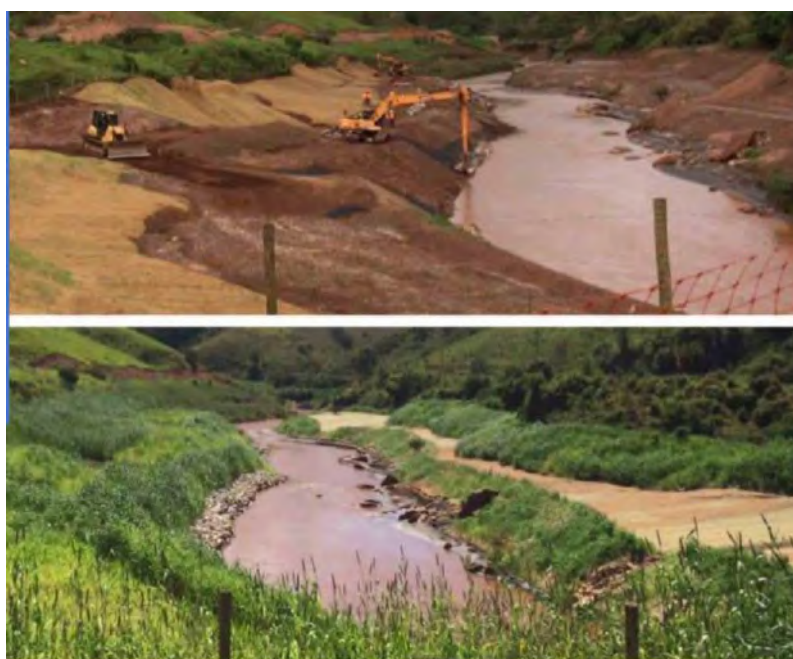
Figura 58 Exemplo da Reconformação do Leito de cursos D'água pelo Rompimento da Barragem de Fundão em Mariana – MG
