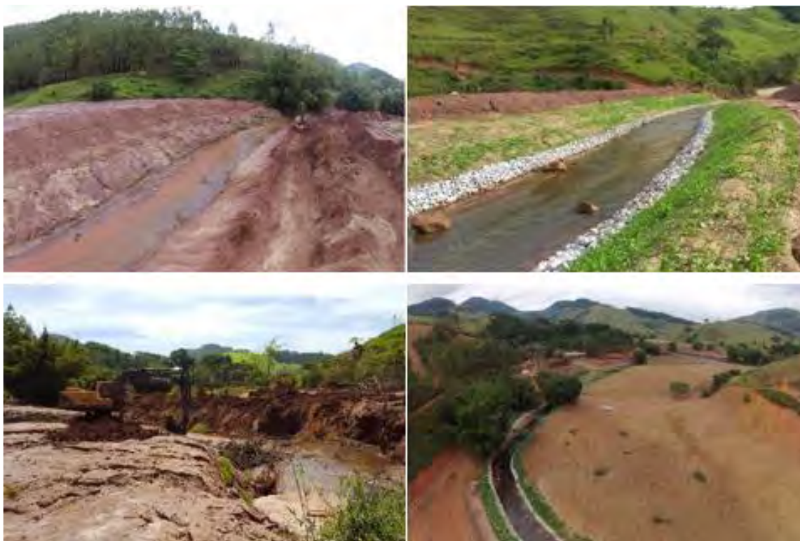
Figura 57 Exemplo da Reconformação do Leito de cursos D'água pelo Rompimento da Barragem de Fundão em Mariana – MG
