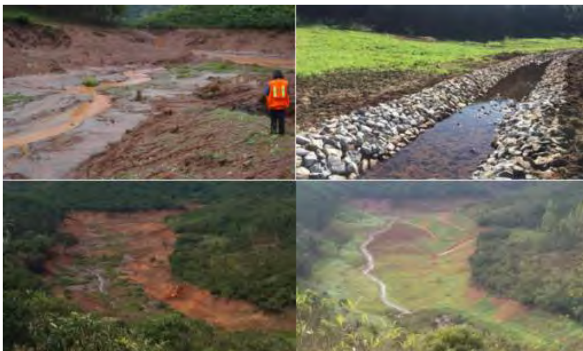
Figura 56 Exemplo da Reconformação do Leito de cursos D'água pelo Rompimento da Barragem de Fundão em Mariana – MG
